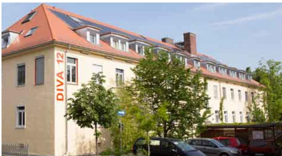
de darauf abgestimmt sowie die alten durch neue, farblich wärmere und hellere Biberschwanzziegel ersetzt.
