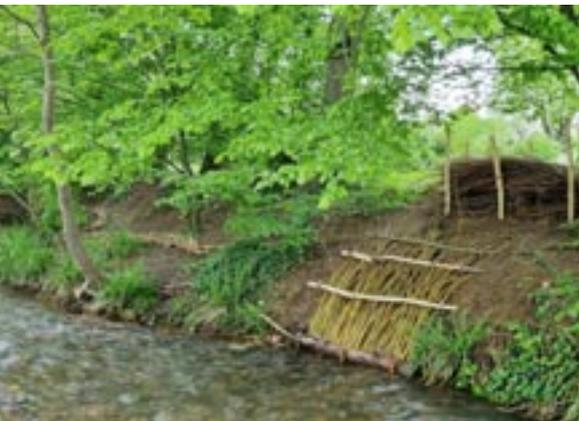
Außerdem wurden an drei Stellen „Spreitlagen“ angelegt – eine ingenieurbiologische Bauweise aus lebenden Weidenkonstruktionen, die zum Schutz von erosionsgefährdeten Uferhängen gesetzt werden. Mittlerweile haben die Weidenrouten ausgetrieben und das erste Hochwasser gut überstanden ... Eine von den Bachpaten aufgestellte Gabione wurde
