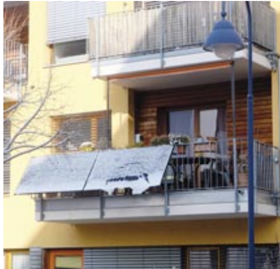
Balkon-Solar-Anlage nach Schneefall. Foto: R. Schepers
