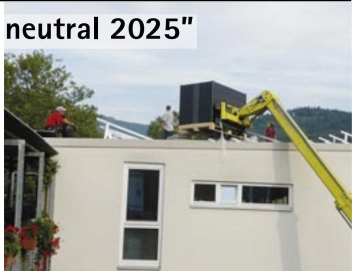
Mit Hubbühne schnell gemacht: Erweiterung einer PV Anlage bei Genova.
